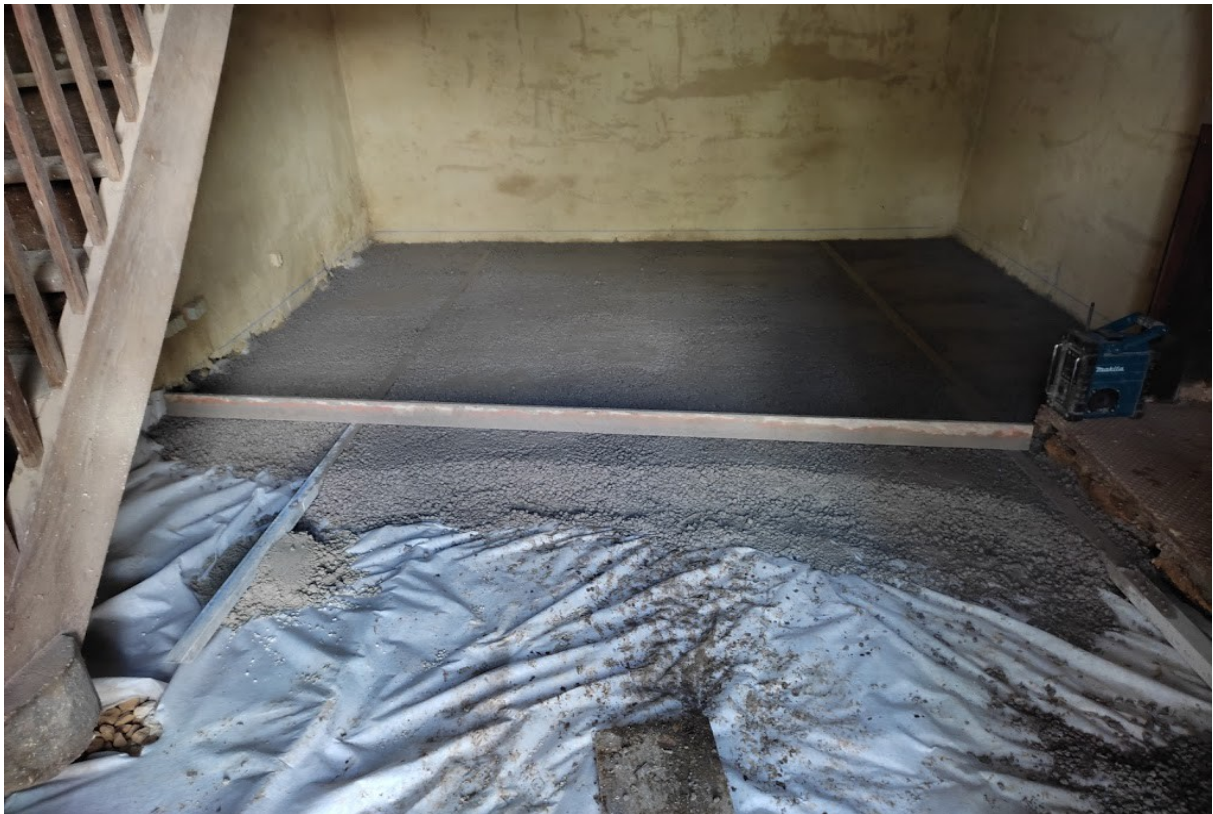
Phase d'apport de matière et de tirage à la règle d'une Dalle en chaux/Pouzzolane
