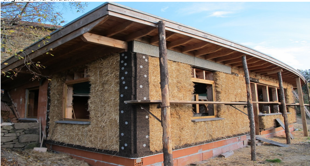
Photo de la construction de la maison de mon maître de stage. Elle est faite en paille porteuse : tout le poids du toit (qui est très lourd en plus car toiture végétalisée) repose sur des bottes de pailles !
